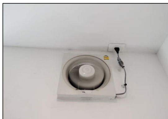
ภาพที่ 27 ระบบระบายอากาศบริเวณห้องพักมูลฝอย
