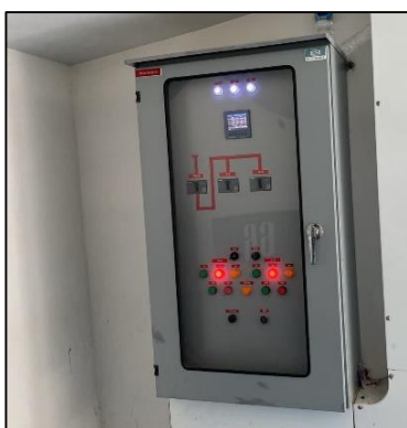
ภาพที่ 41 มิเตอร์ไฟฟ้าระบบบำบัดน้ำเสีย
